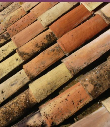
Tuiles canal, tuiles rondes, tuiles romaines, tiges de botte...
